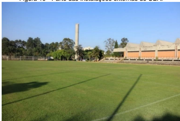
Figura 19 - Parte das instalações externas do CEAF
