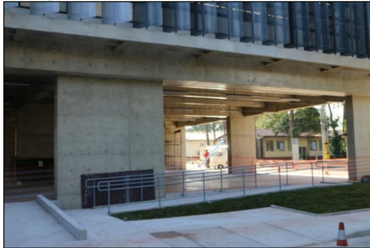
Figura 7 - Rampa de acesso no Bloco W, que também conta com elevadores.
