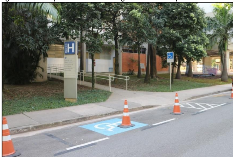
Figura 8 - Rampa de acesso e vaga demarcada para cadeirantes.
