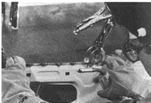
Figura 27 - Solda tampão sendo realizada com arco MIG segundo Durffy e Scharff (2004).
