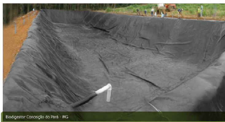
Figura 10 - Biodigestor Modelo Tubular
