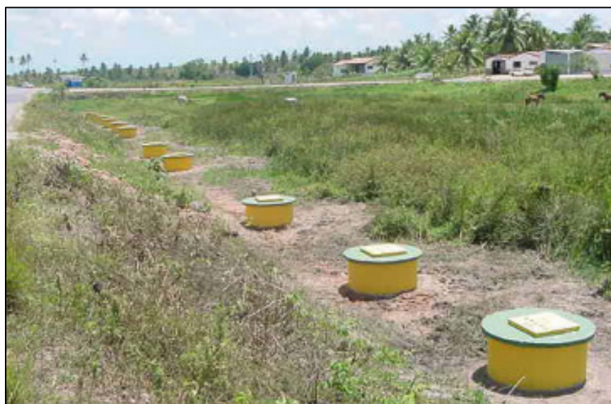
FIGURA 2.14 - Instalação típica de um leito de anodos. FONTE – IBP, 2005
