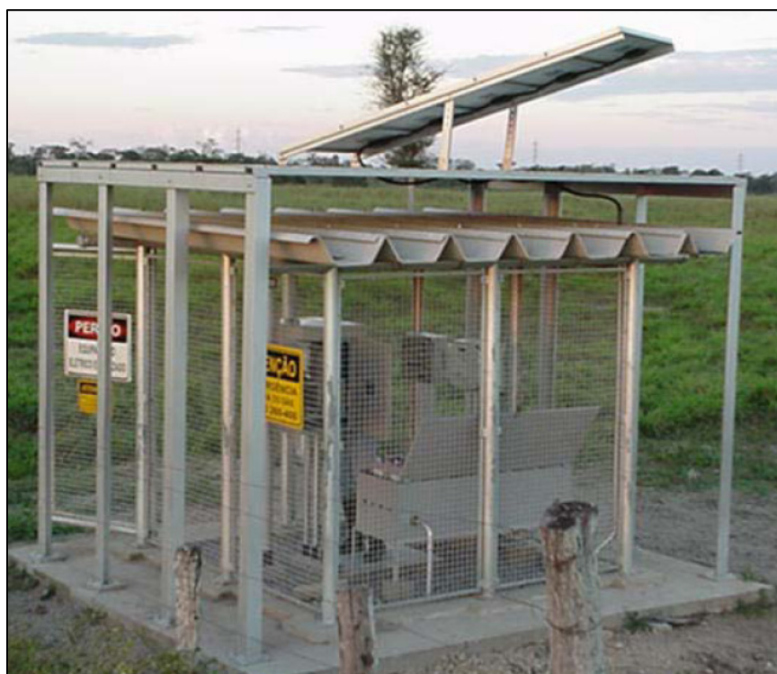
FIGURA 2.15 -Retificador usando energia solar. FONTE – IBP, 2005
