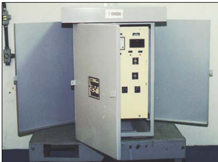
FIGURA 2.12 - Retificador para corrente impressa. FONTE – IBP, 2005
