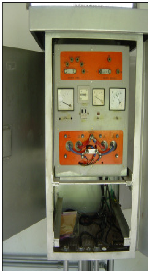
FIGURA 2.13 - Retificador com ajuste de potência. FONTE – IBP, 2005
