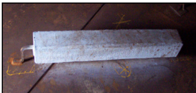
FIGURA 2.9 – Anodo instalado em fundo de tanque. FONTE – IBP, 2005
