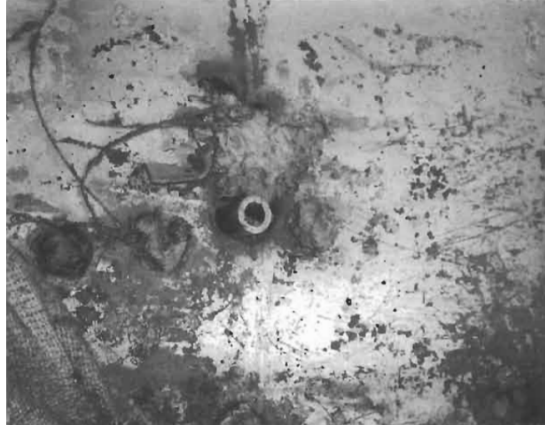
Figura 13: Corrosão em parede de um tanque de armazenagem subterrâneo
