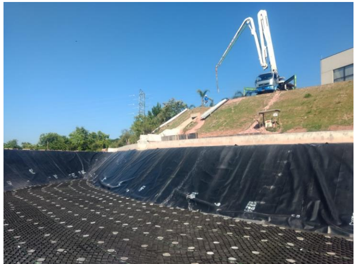
Figura 2 - Lagoa de água industrial revestida com nova geomembrana
