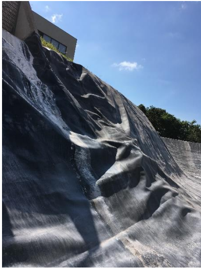
Figura 2 – Lagoa de água industrial revestida com geomembrana antiga Fonte: Fernando Luiz Lavoie (2019)
