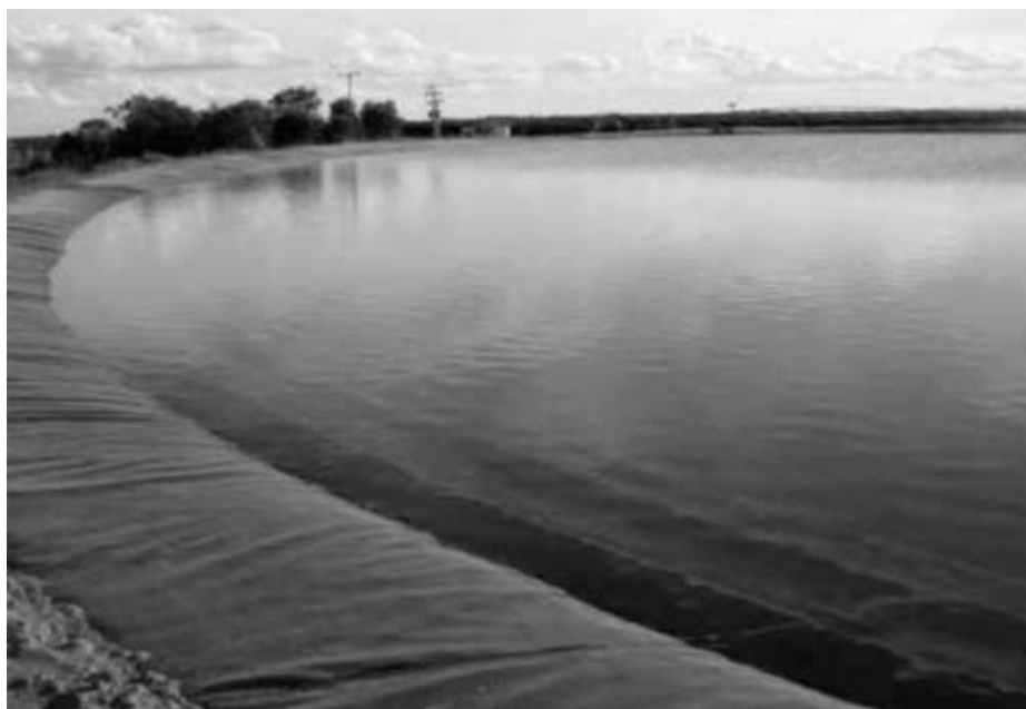
Figura 1: Reservatório de água para irrigação revestido por uma geomembrana.
