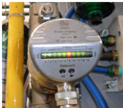
Figura 5 - Sensor de Fluxo de água para refrigeração (Tomoana GM)
