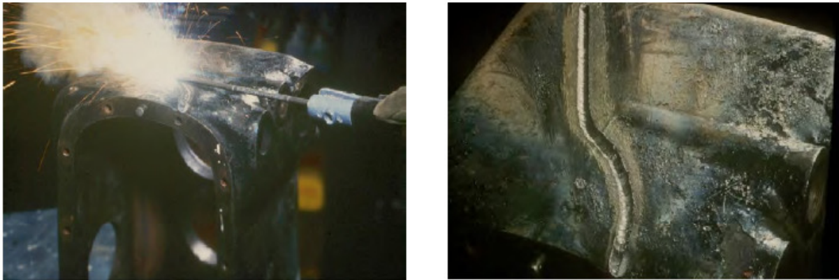
Figura 9 – Chanfro executado com eletrodo metálico
