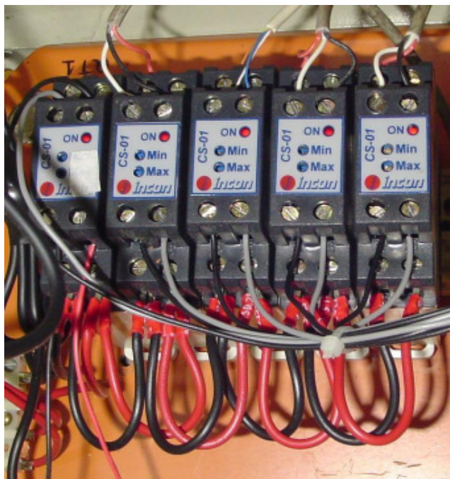
Figura 45 - Condicionadores de sinais para medidas de temperaturas e atuação no conversor I/P da válvula eletropneumática de vapor.
