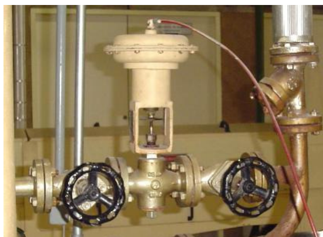
Figura 30 - Válvula eletropneumática de controle do vapor de aquecimento.
