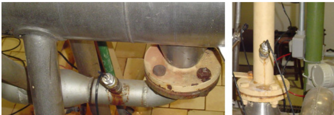
Figura 36 - Posicionamento dos elementos de medição das temperaturas da entrada (T4) e saída (T2) da água quente de aquecimento.
