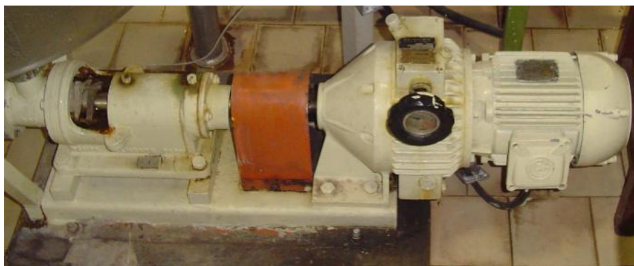
Figura 28 - Bomba de deslocamento para fluido de processo.
