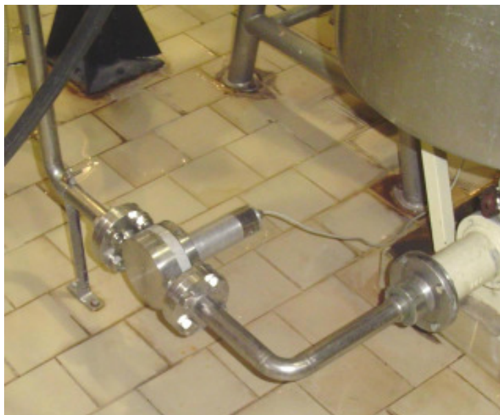
Figura 39 - Instalação do medidor de vazão METROVAL modelo OI-2 SMRX/FS.
