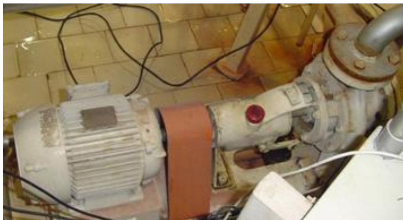
Figura 29 - Bomba centrífuga para circulação de água quente.
