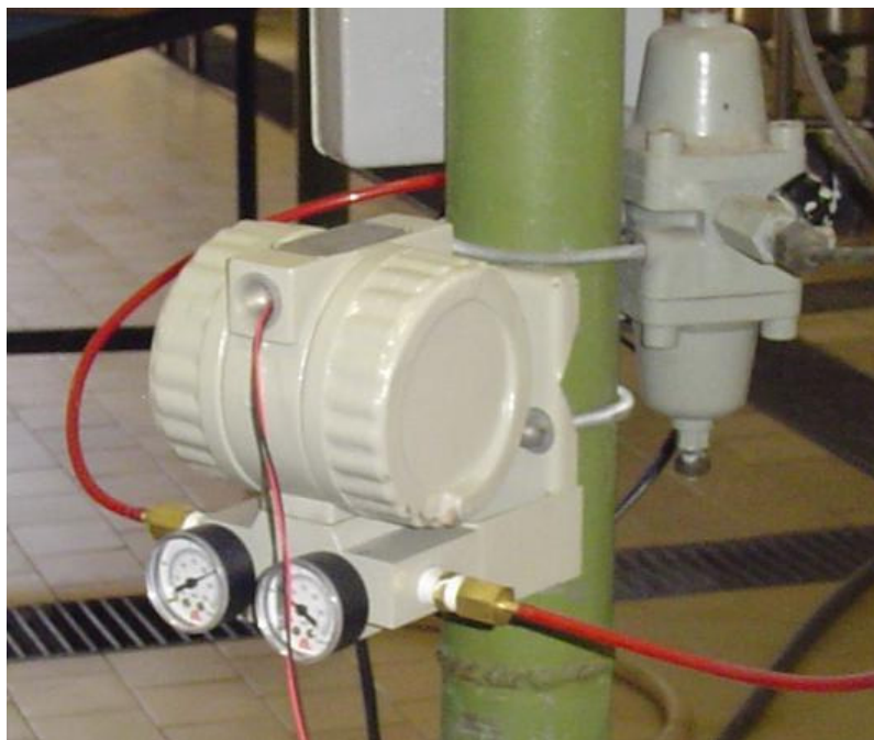
Figura 44 - Conversor I/P ENGINESTREL, modelo 621IPB
